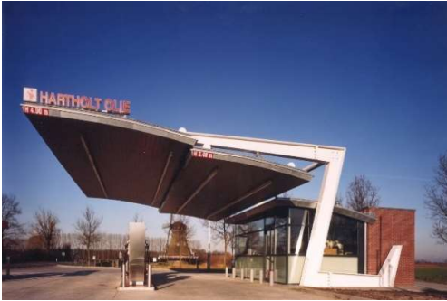
Gasstation Windesheim Wijhense Weg 45.
